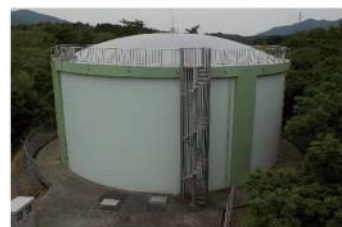
愛宕山配水池
