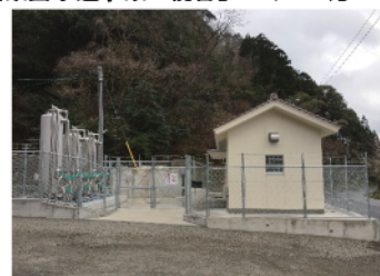
美保塩津浄水場
