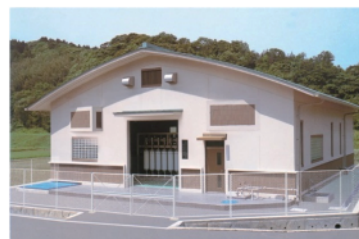
多伎膜処理施設棟
