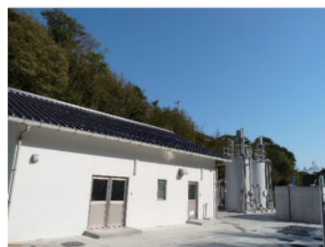
日御碕浄水場
