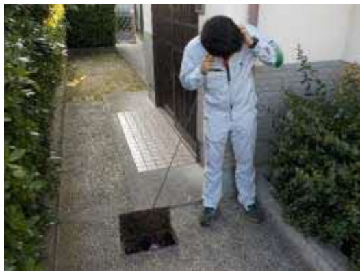
漏水調査(管路、給水装置)
