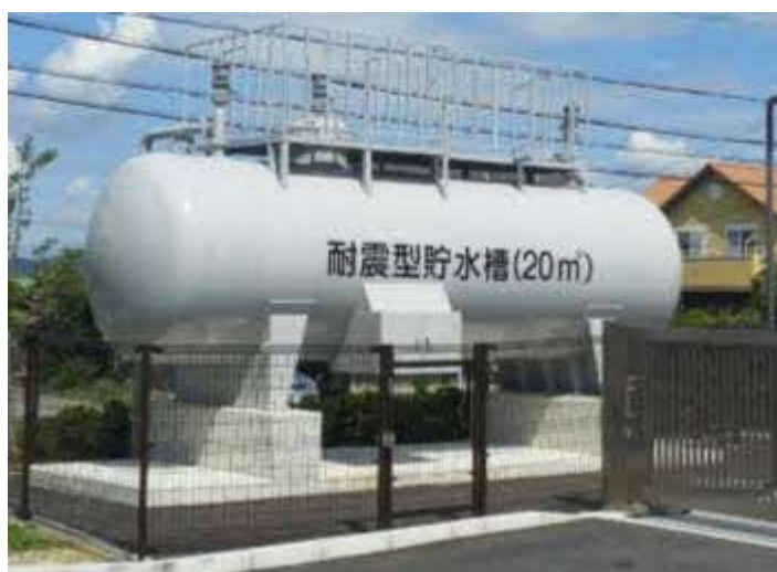
耐震性緊急貯水槽
