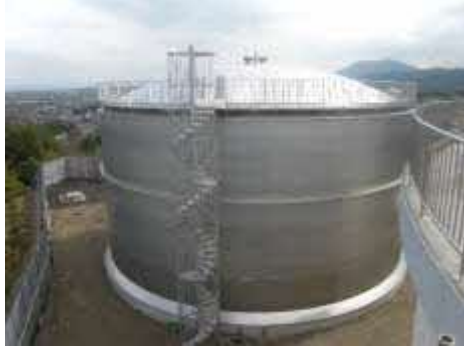
耐震性の高い新向山第2配水池（容量3,300m 3 ）
