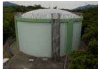
愛宕山配水池
