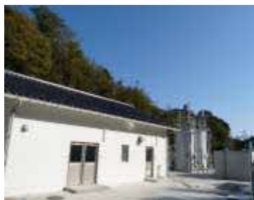
日御碕浄水場
