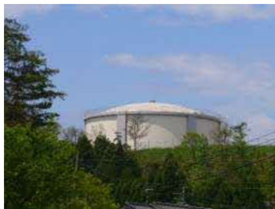
新向山配水池（容量 7,000 m 3 ）
