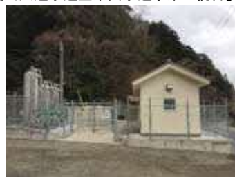
美保塩津浄水場
