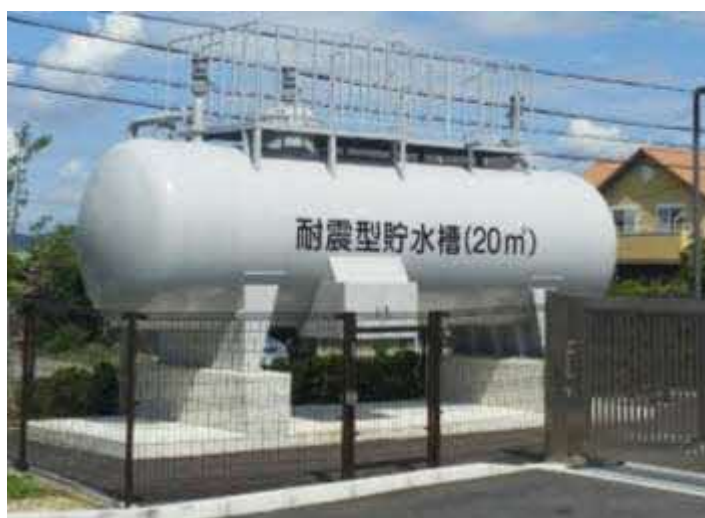
耐震性緊急貯水槽
