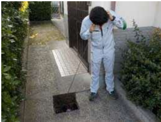
漏水調査(管路、給水装置)
